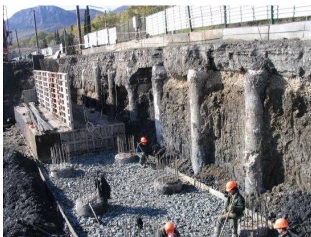
Рис.1. Укрепление дорожного полотна буронабивными сваями для сдерживания оползневых процессов на Южном берегу Крыма
